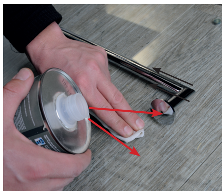
2. Odmaštění styčných ploch 2. Degrease the contact surfaces
